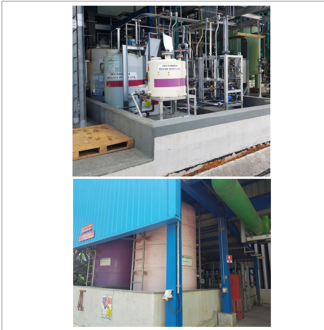
รูปที่ 2.7-3 ตัวอย่างการจัดเก็บสารเคมีบริเวณพื้นที่ใช้งานที่จำเป็นต้องใช้งานในกระบวนการผลิตอย่างต่อเนื่อง
