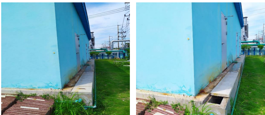
รูปที่ 2.7-4 รายละเอียดและบ่อรวบรวมบริเวณอาคารอเนกประสงค์ของโครงการ
