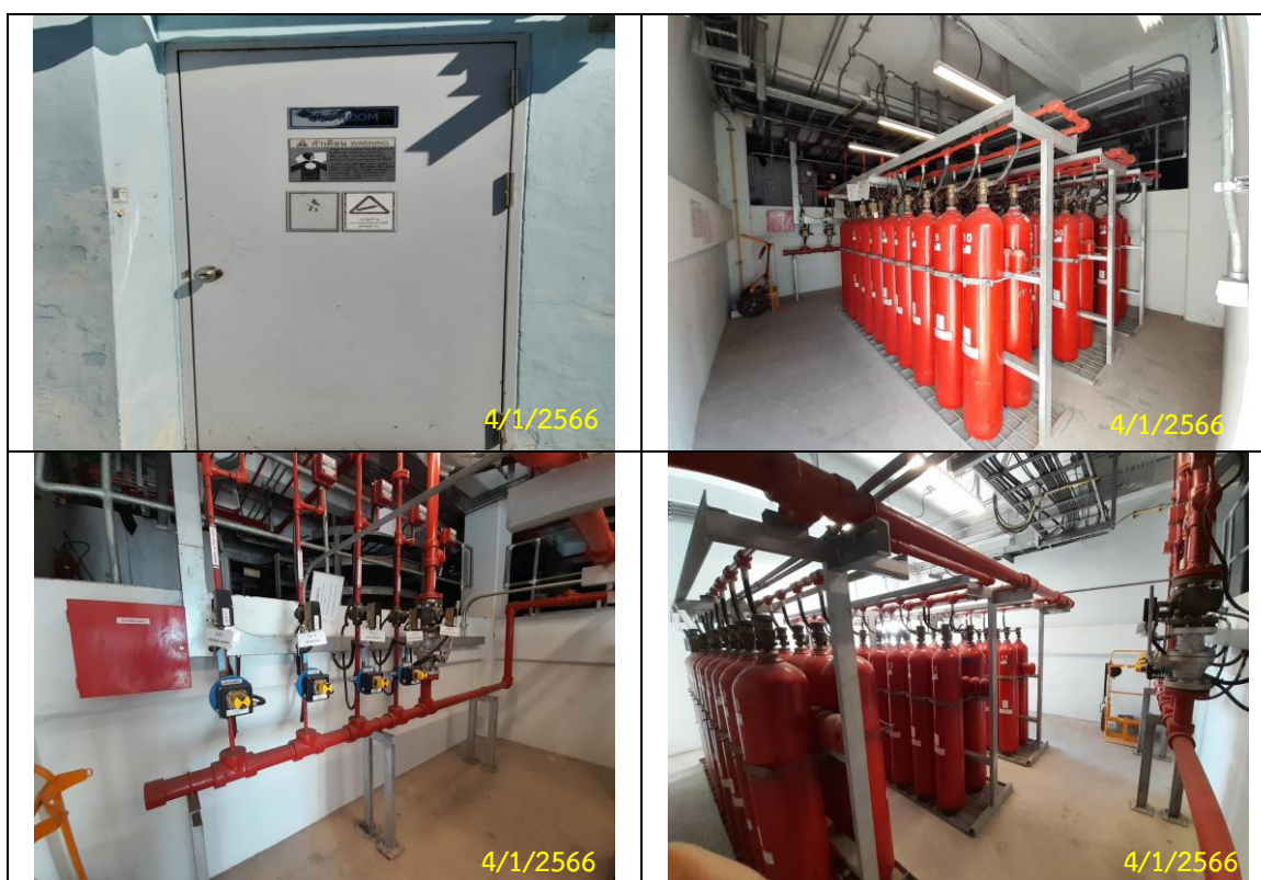
รูปที่ 2.14.2.3-2 ภาพถ่ายแสดงการติดตั้ง Automatic CO 2 System บริเวณอาคารควบคุมระบบ ของโครงการ
