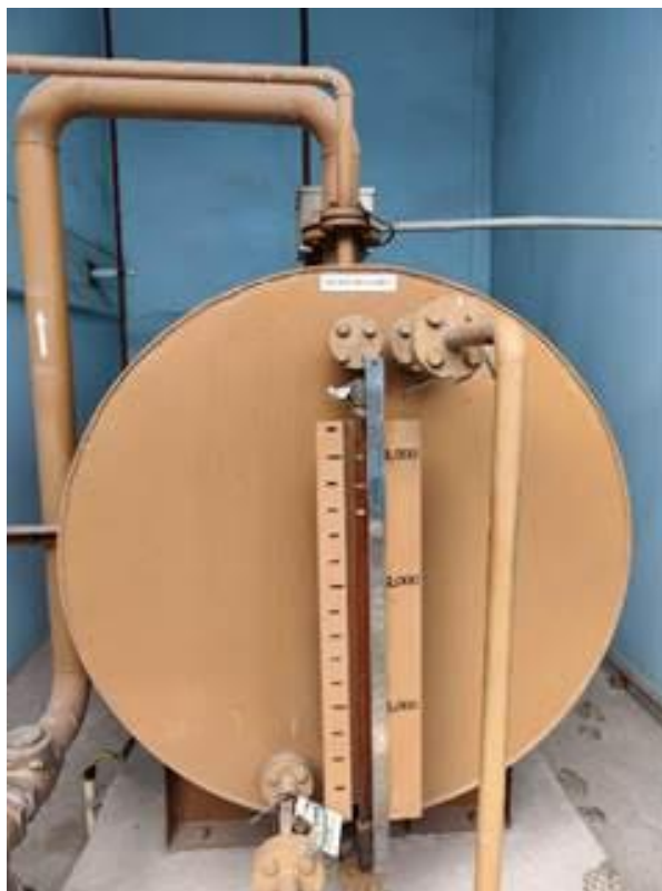
รูปที่ 2.6.2-1 ถังสำรองน้ำมันดีเซลสำหรับ Emergency Diesel Generator ภายในโครงการ
