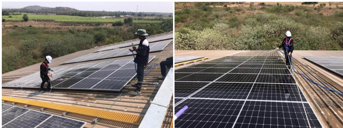
รูปที่ 2.13.3.2-1 การล้างทำความสะอาดแผงเซลล์แสงอาทิตย์บนหลังคา
